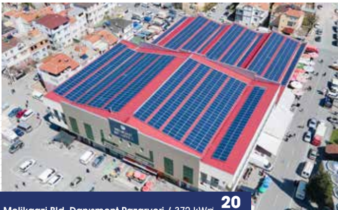
Melikgazi Bld. Danışment Pazaryeri / 372 kWp
