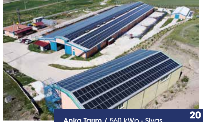
Anka Tarım / 560 kWp - Sivas
