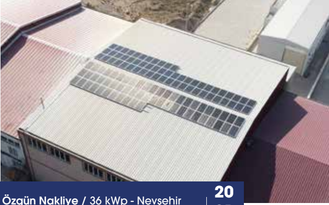
Özgün Nakliye / 36 kWp - Nevşehir
