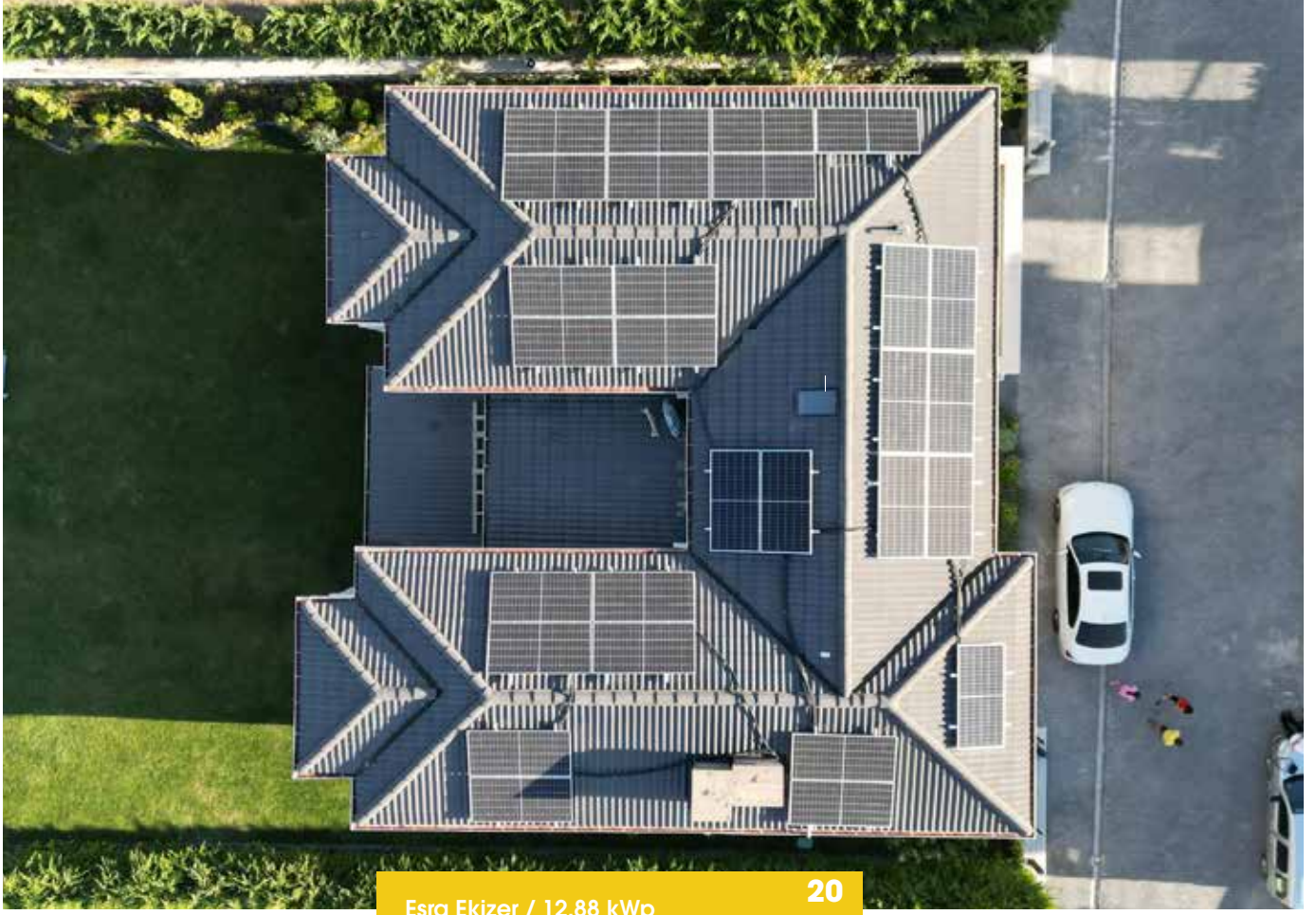
Esra Ekizer / 12,88 kWp
