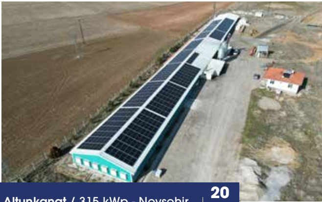
Altunkanat / 315 kWp - Nevşehir
