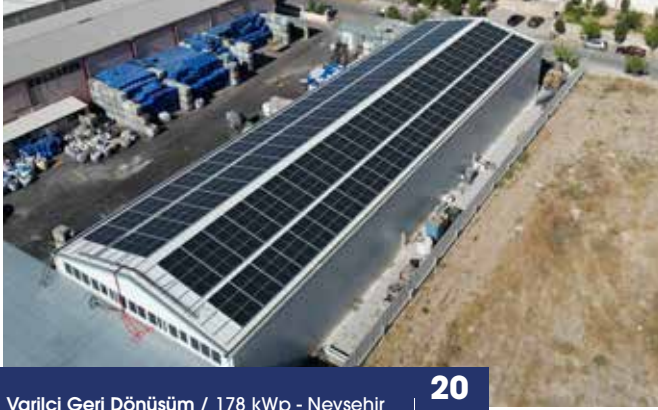
Varilci Geri Dönüşüm / 178 kWp - Nevşehir
