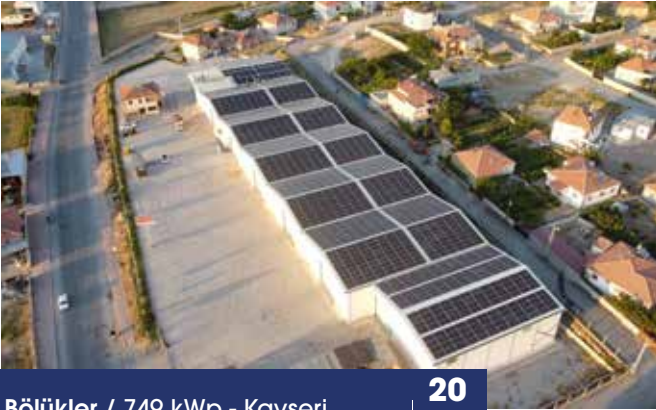
Bölükler / 749 kWp - Kayseri | 20 22
