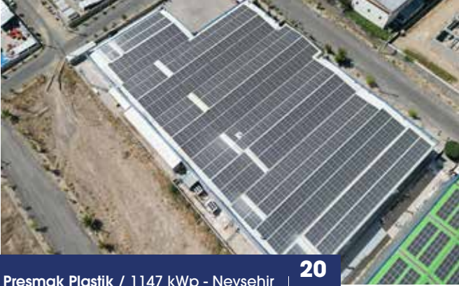
Presmak Plastik / 1147 kWp - Nevşehir | 20 22
