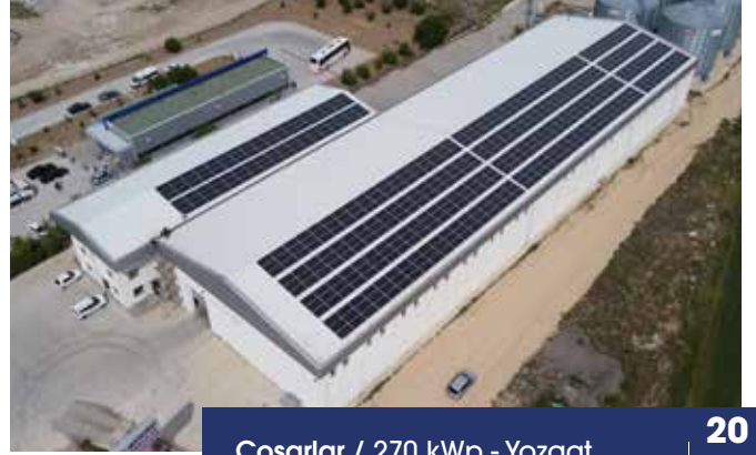
Coşarlar / 270 kWp - Yozgat
