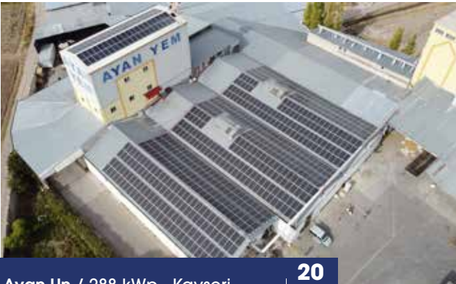
Ayan Un / 288 kWp - Kayseri
