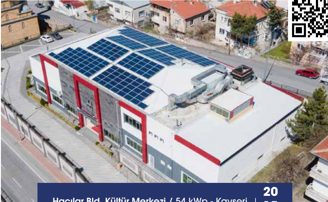
Hacılar Bld. Kültür Merkezi / 54 kWp - Kayseri
