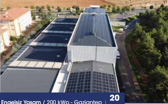
Engelsiz Yaşam / 200 kWp - Gaziantep
